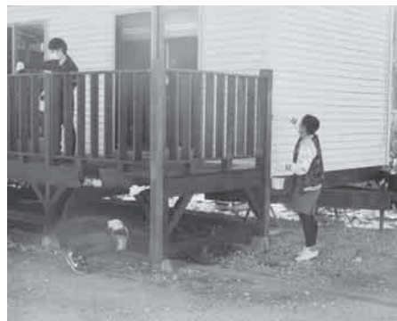
ウッドデッキのペンキ塗り
